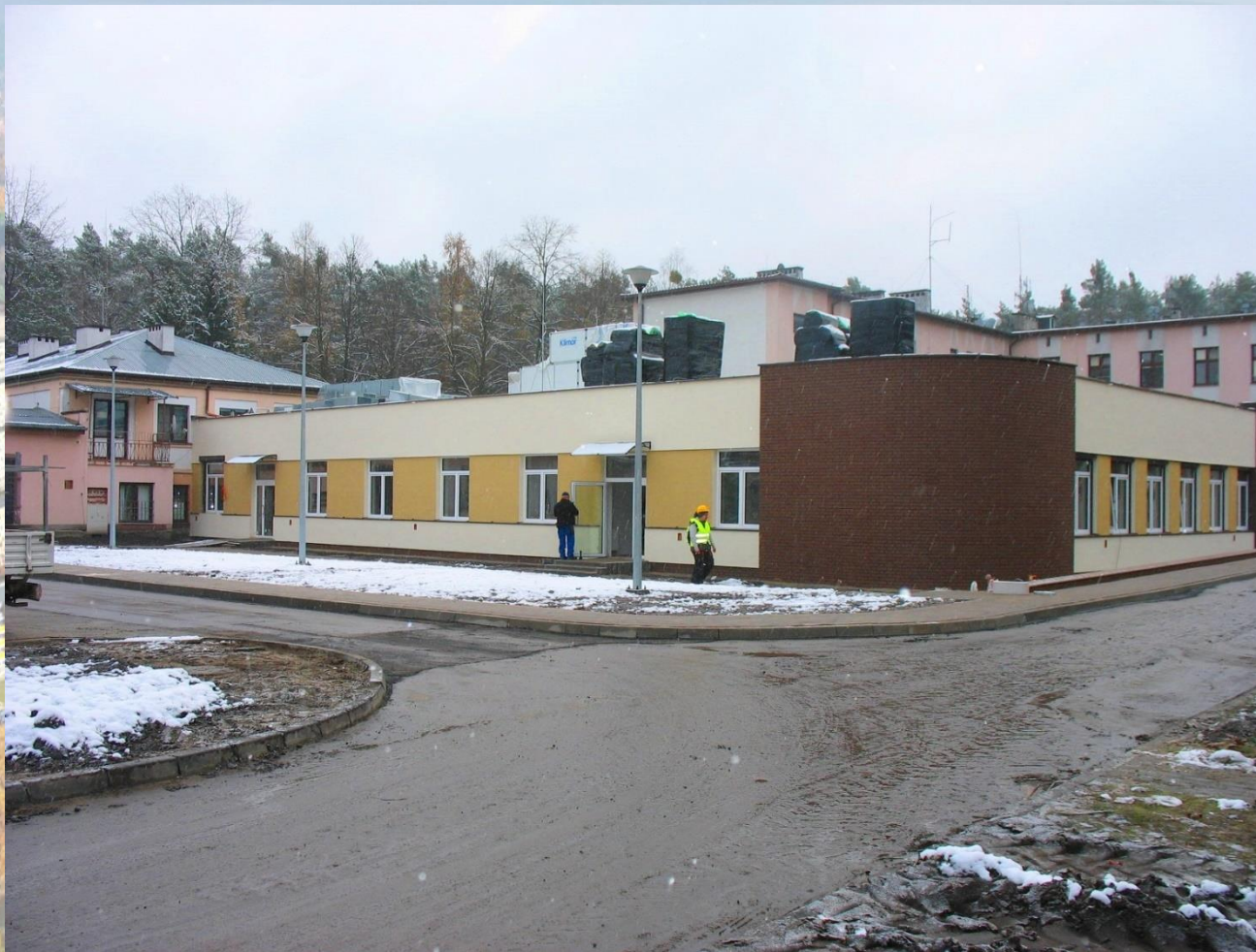
Rozbudowa szpitala powiatowego
