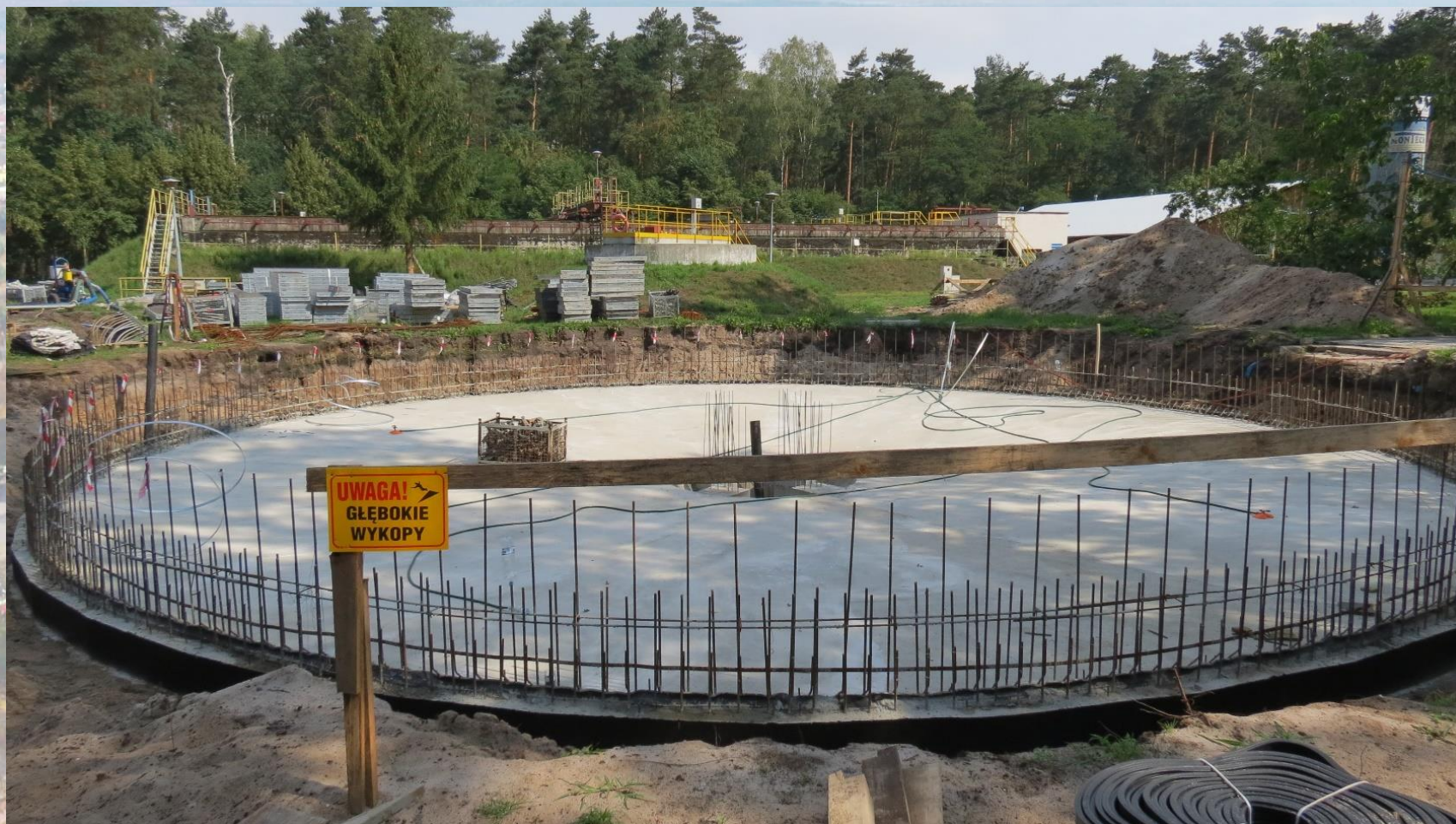
Rozbudowa oczyszczalni ścieków
