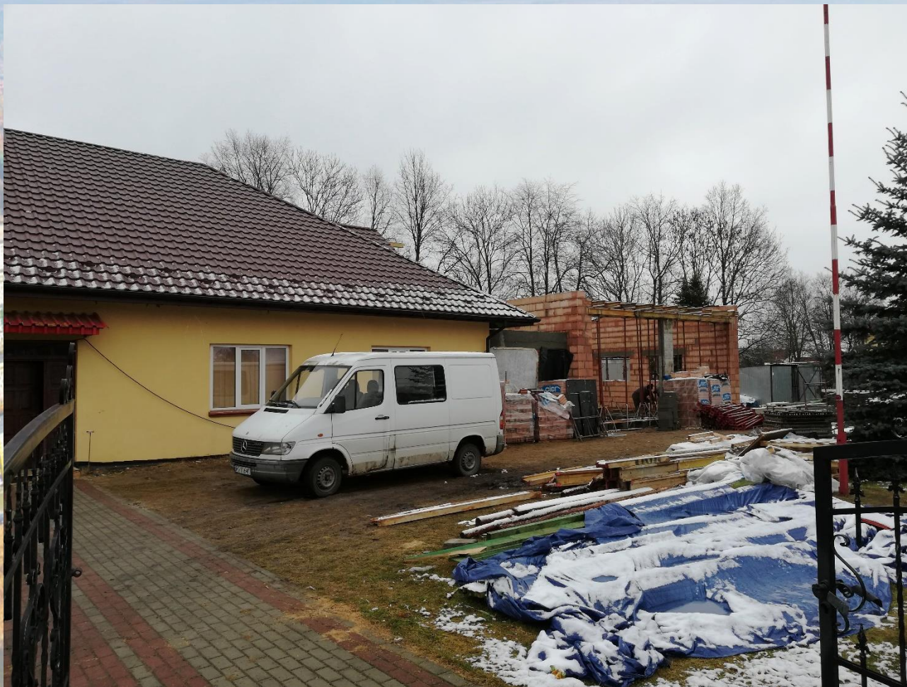
Rozbudowa remizy OSP Jadachy
