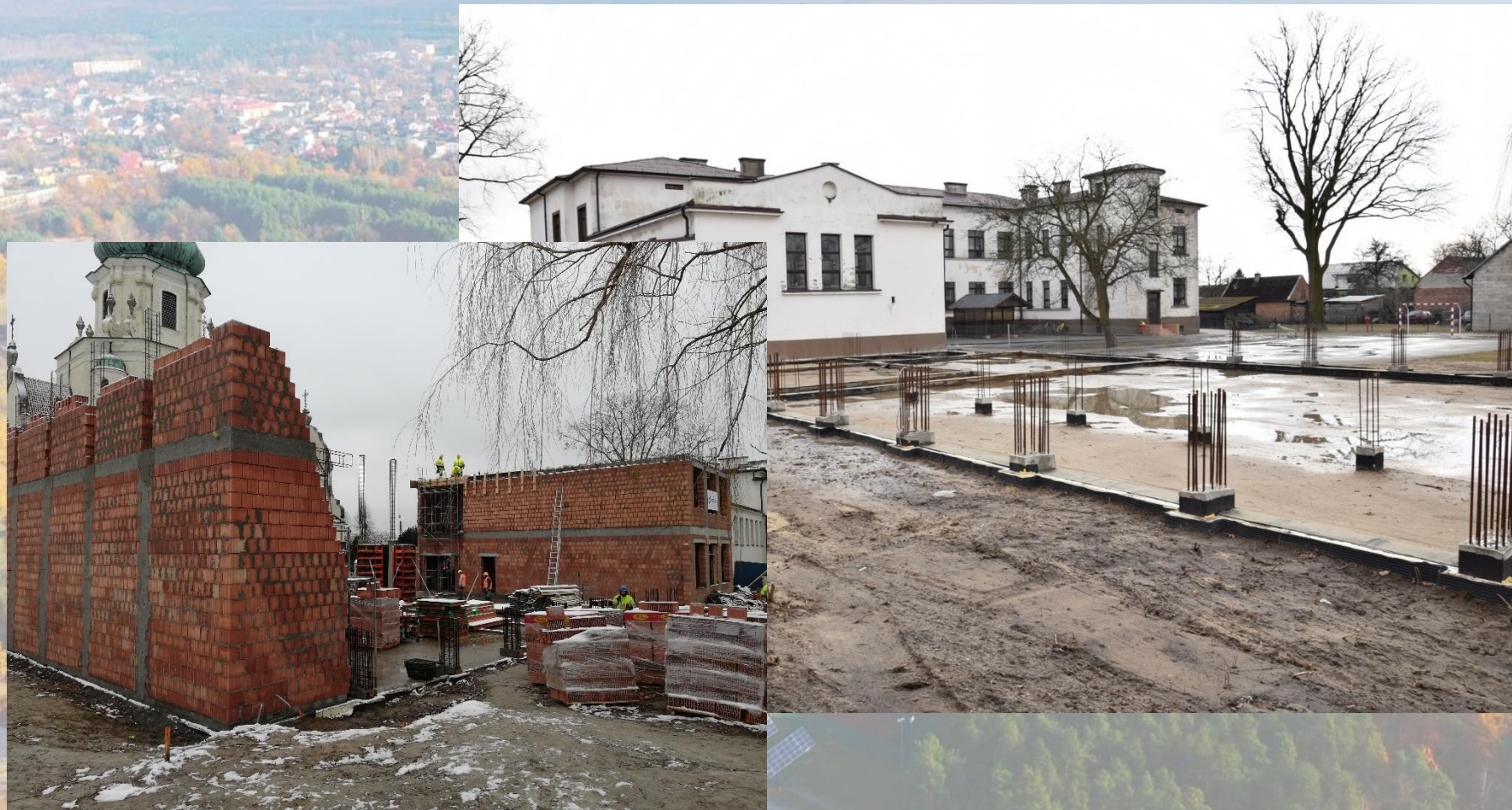
Budowa sali gimnastycznej przy SP w Chmielowie
