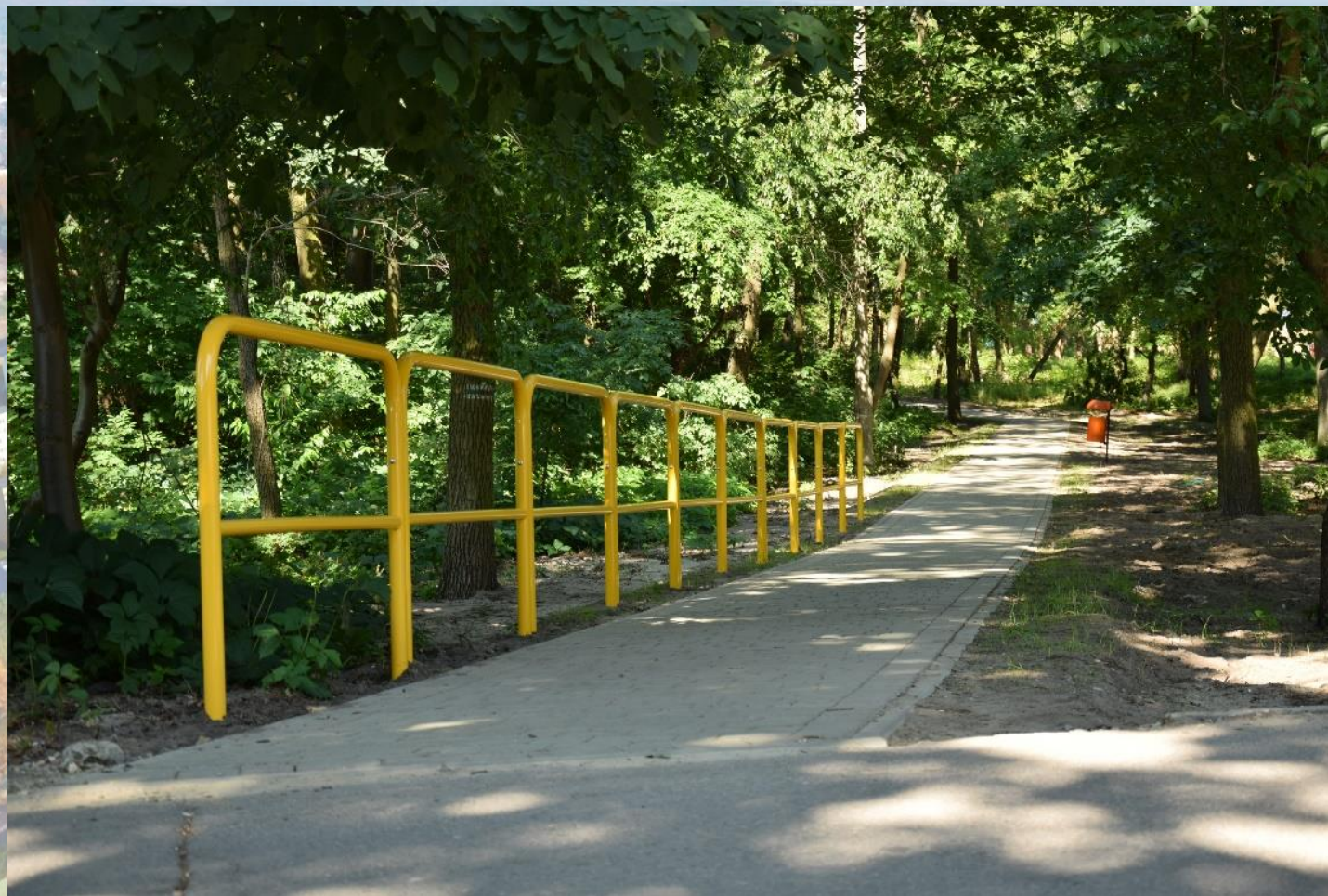
Wyremontowany chodnik do basenu
